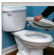
Instale el asiento en el sanitario.
